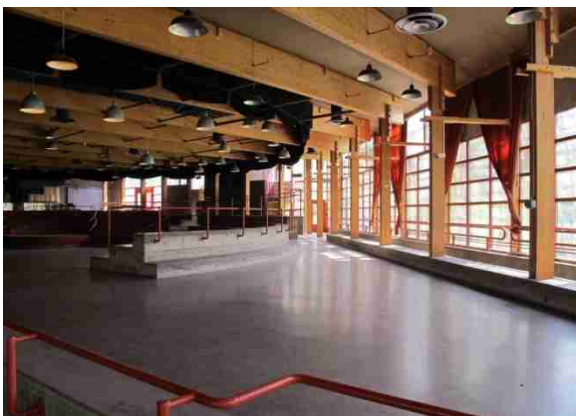
Primär och sekundärbärning. Foto mot sydväst.
