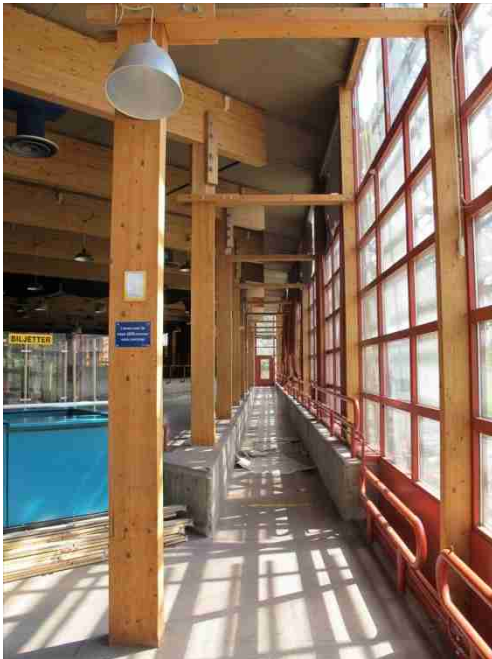
Invändig gång utmed sydvästra väggen
