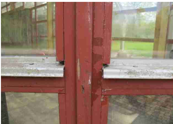
Detalj av fönster parti.
