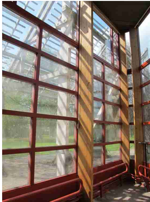
Glasparti i sydvästra väggen med bärning
