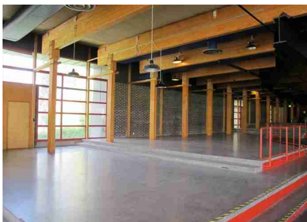
1 Norra fasaden mot nordost.
