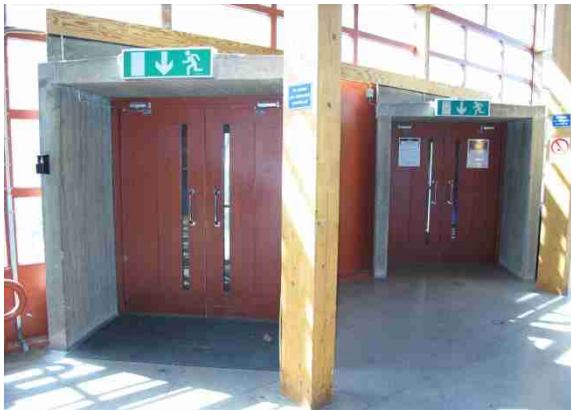
Huvudentréer i sydvästra fasaden.
