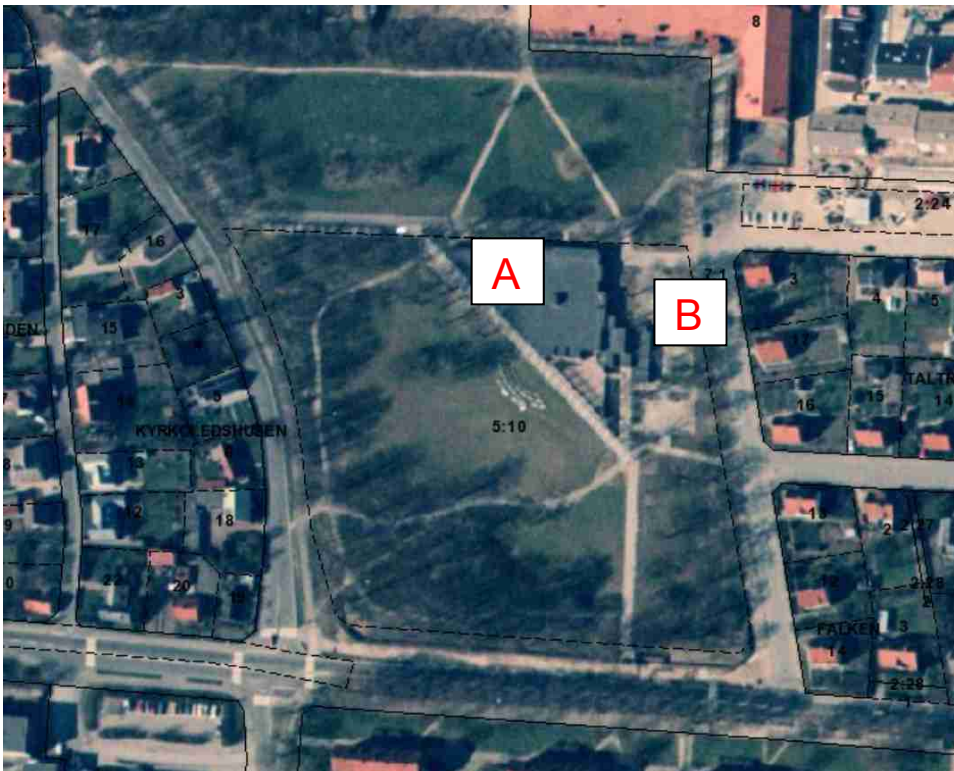
Flygbild från 1978 med den nya folkparksbyggnaden placering. Samtliga äldre folkparksbyggnader är nu rivna. Foto Stadsbyggnadskontoret i Lund.
