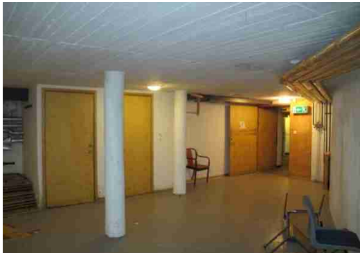
Förrådsutrymme med betongbjälklag och pelare. Foto åt sydost.
