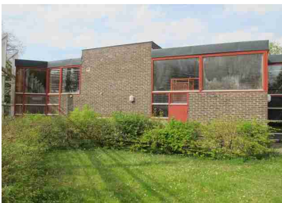
Varierande och olika stora fönsterluffer i anslutning till tak. Södra fasaden mot gård.
