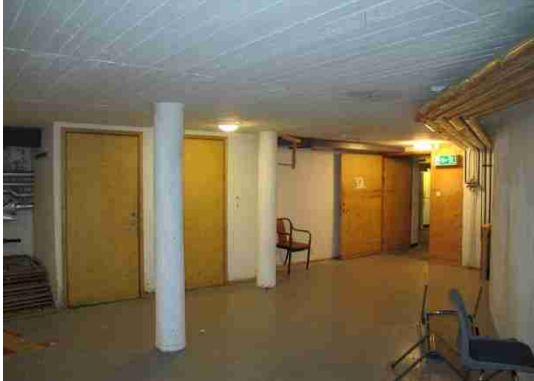
Förråd i mellersta källaren. Foto mot sydost.
