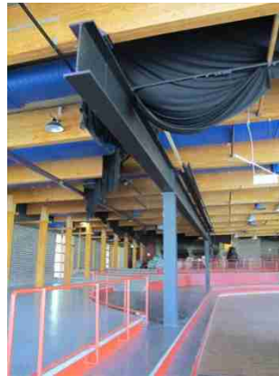
Stålbärning i öst-västlig riktning på stålpelare.
