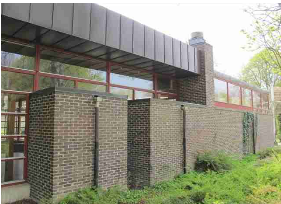
Varierande och olika stora fönsterluffer i anslutning till tak. Plåtinklädnad rymmer ventilationskanaler. Norra fasaden.
