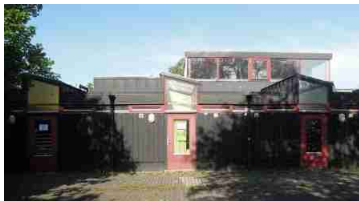
Ljuslanterner och snedställda takfönster i anslutning till Utgångsdörrar i östra fasaden på byggandsdel B.
