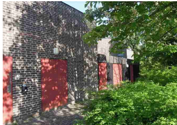
Östra fasaden med personalingångar och nödutgångar. Förråd i trä kompletterar den här indragna fasadmuren.
