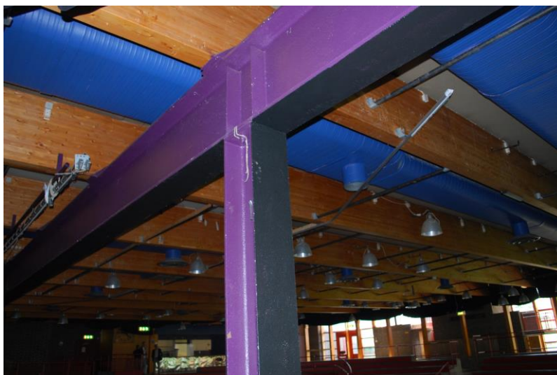
Bild 3. Stålpelare och balk, som avlastar limträbalkar, del A. Bild: Malena Larsvall
