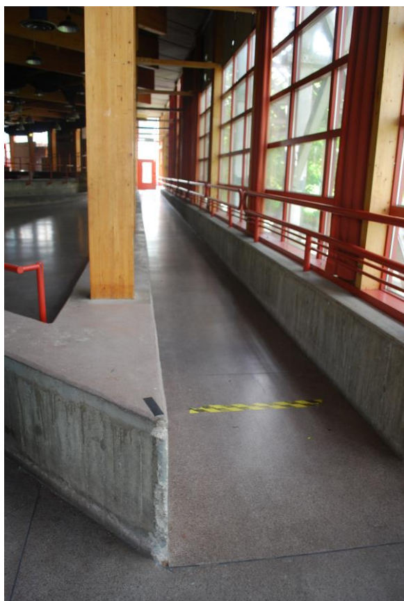
Bild 5-6. Glaspartier i fasad mot sydväst/nordväst.. Limträpelare stabiliserar posterna som glaset är infästa i. Bilder: Malena Larsvall
