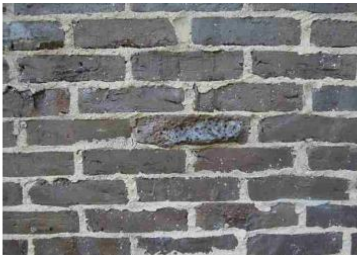
Bild 8. Närbild av kanalmur. En del tegel är så hårt brända att de börjat sintra i ytan. Bild från Antikvarisk förundersökning, Tyréns
