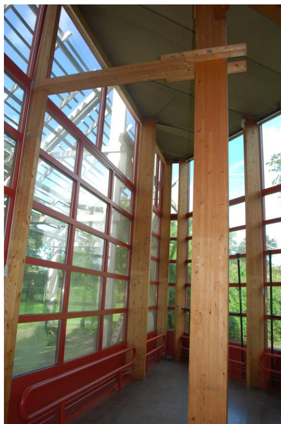
Bild 5-6. Glaspartier i fasad mot sydväst/nordväst.. Limträpelare stabiliserar posterna som glaset är infästa i. Bilder: Malena Larsvall
