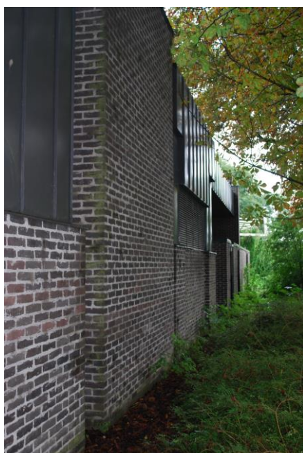
Bild 7. Fasad mot nordväst, del A. Kanalmur av helsingborgstegel, tillverkat i Hög. Bild: Malena Larsvall
