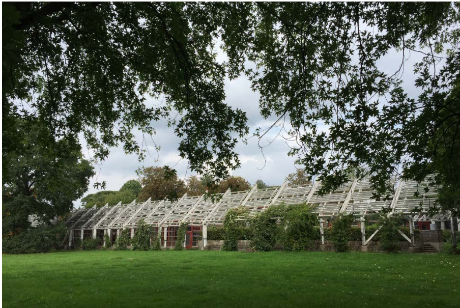
Folkparksbyggnadens västra sida med pergola och klätterväxter.
