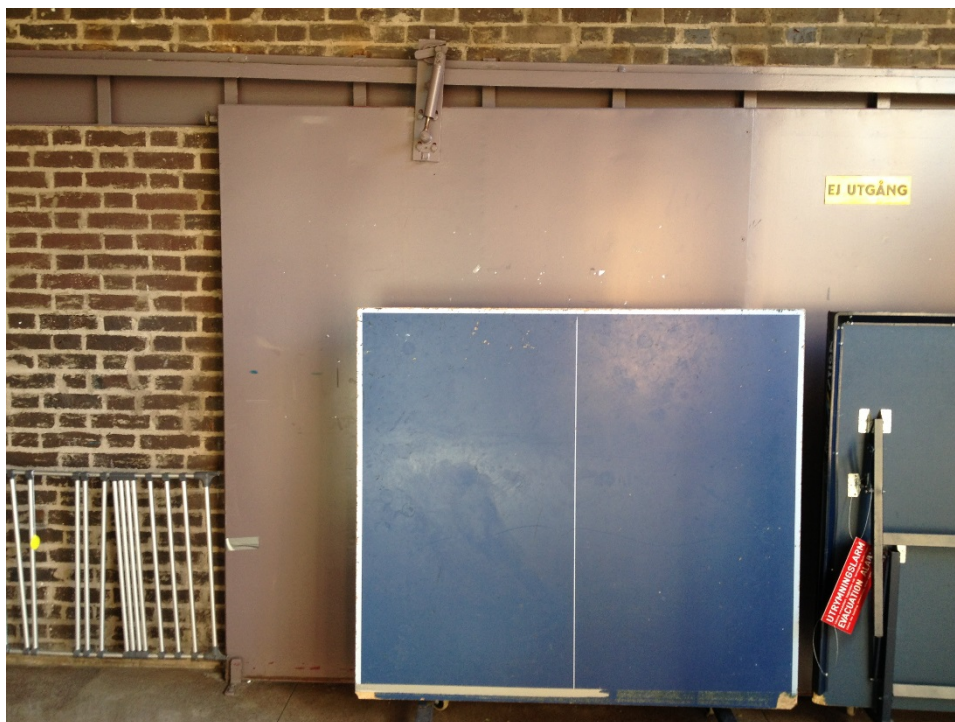
Skjuddörr mellan lokalerna
