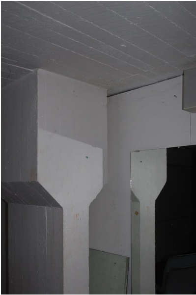
Källarens pelarstöd med holkar för limträpelarna
