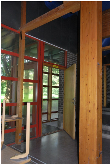
Nedgång till källare i norra kanten
