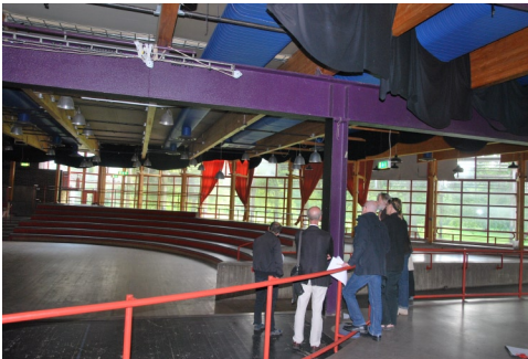
Öst-västlig stålbalk som stöd för limträbalkar
